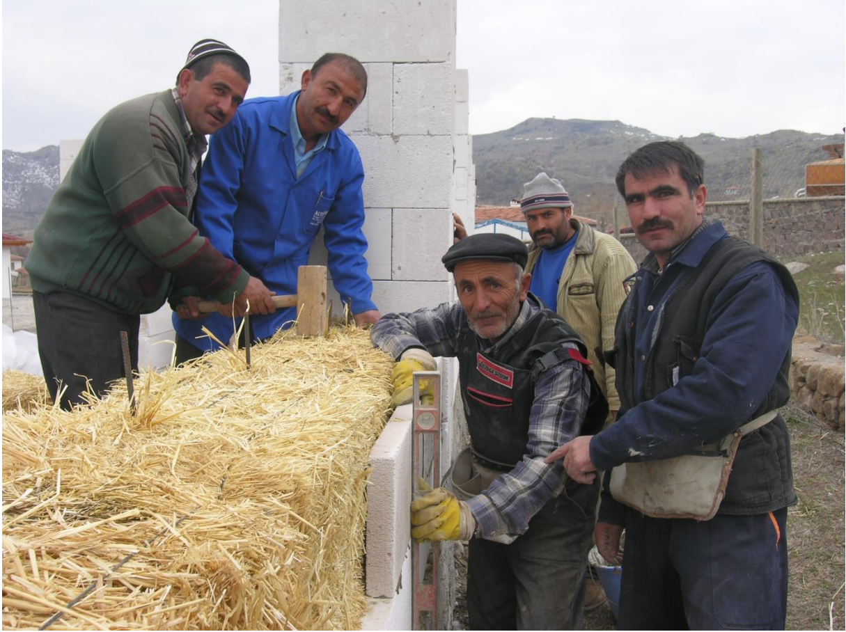
Şekil 20. Köy erkekleri tarafından inşa edilen gazbeton kolonları ve dışarıdan gazbeton levhalarıyla korunmuş saman balya duvarlı özgün hibrit sistem
