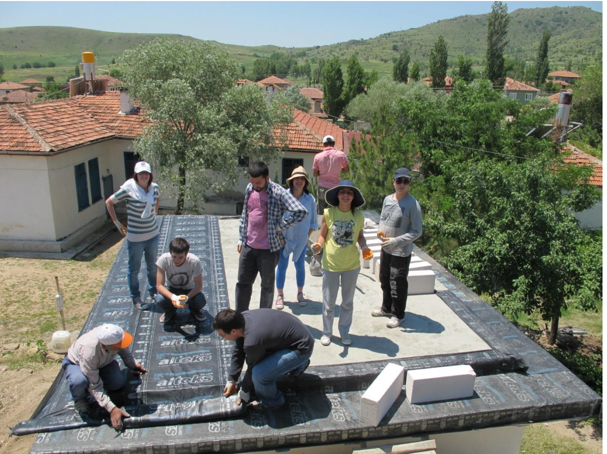
Şekil 18-19. Uygulamalı ARCH 325 dersi kapsamında ODTÜ öğrencilerinin kerpiç evin ısı performansını arttırarak daha verimli çalışabilmesi için çatı yalıtımını yapmaları
